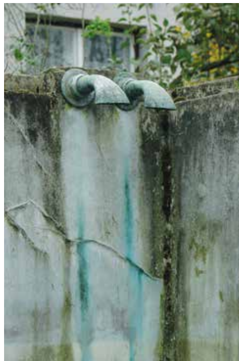
Obr. 40: Armatury pro napouštění vody (foto Vlasta Loutocká, 2015)
