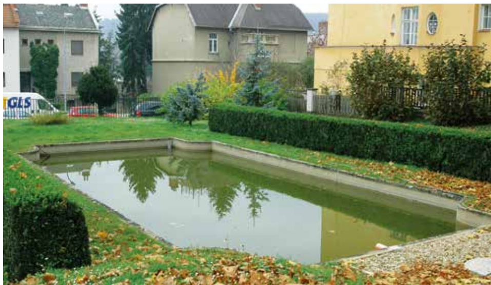
Obr. 36: Okrasný bazén před Bulínovou vilou (foto Vlasta Loutocká, 2015)
