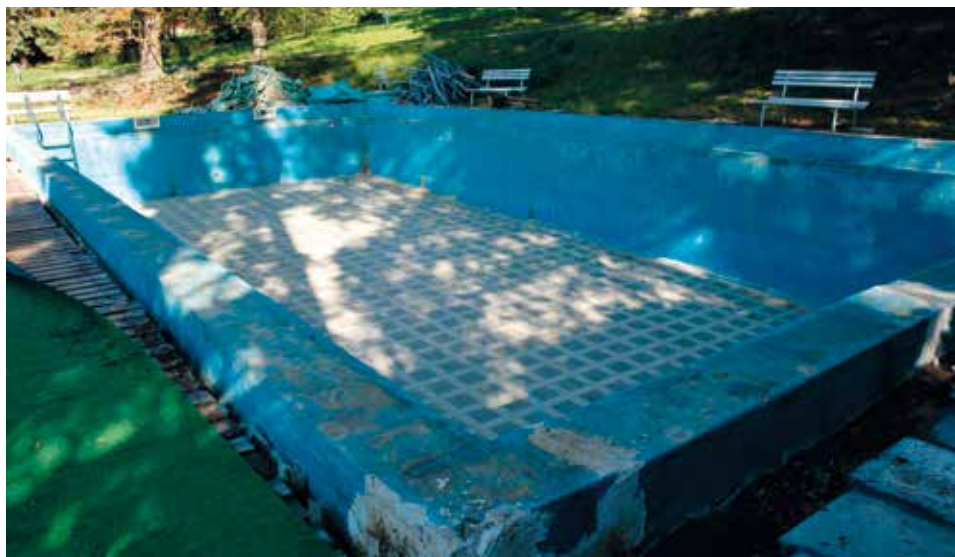
Obr. 50: Bazén od jihovýchodu (foto Petr Czajkowski)
