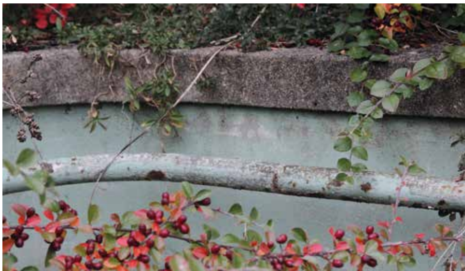
Obr. 32: Bazén v zahradě u viily Wittalových – detail (foto Vlasta Loutocká, 2015)
