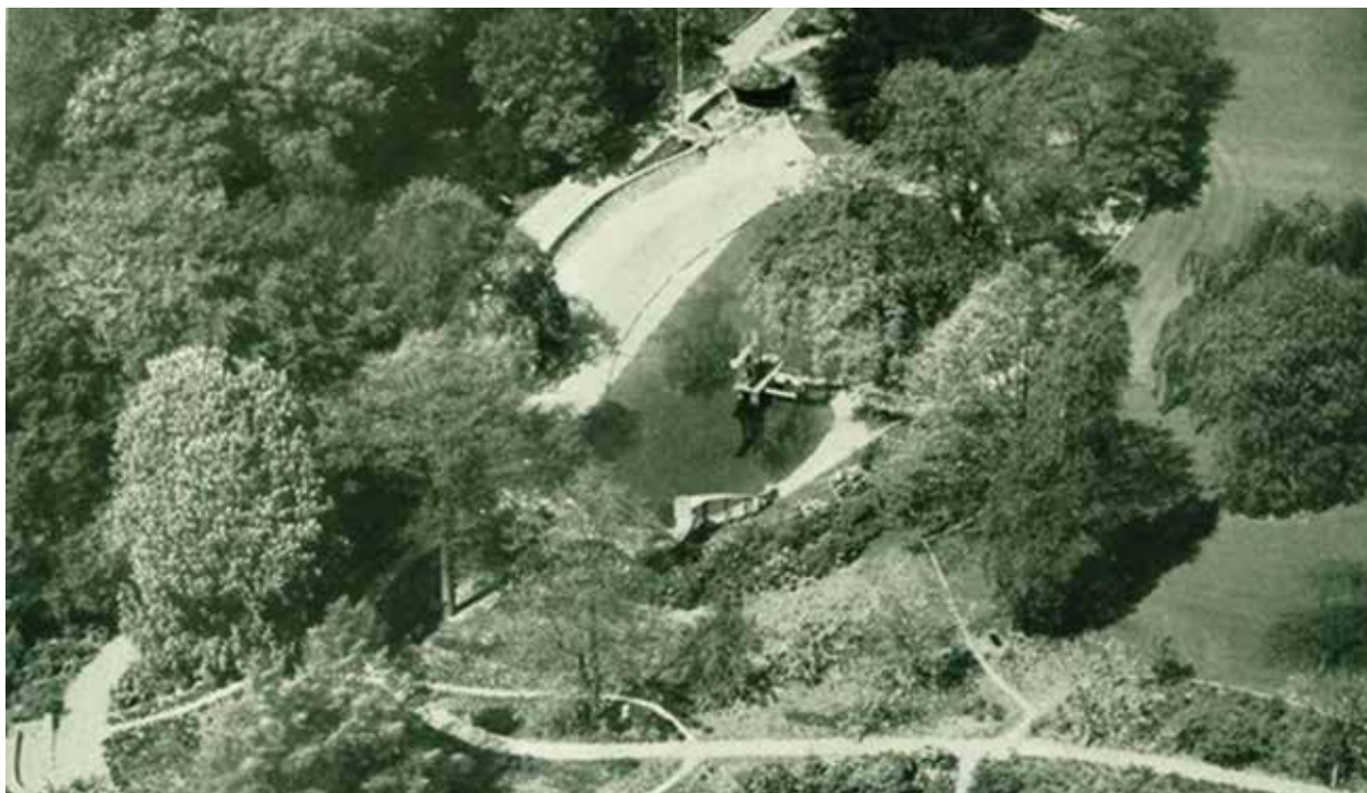
Obr. 20: Bazén se skokanskou věží a skluzavkou (foto archiv autorů)
